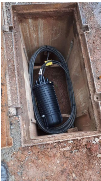
Figura 12. Exemplo de caixa de chegada de fibras.
