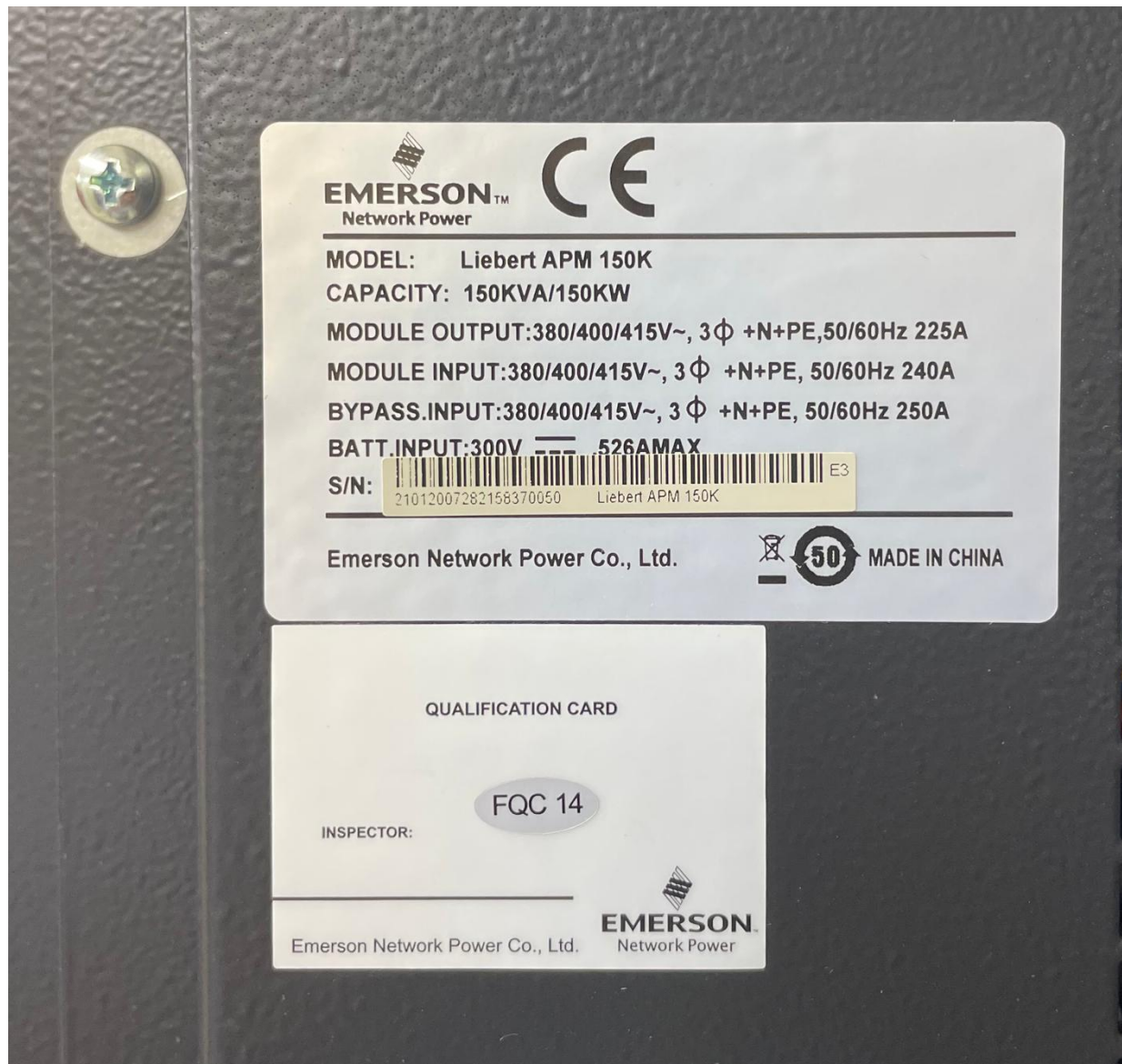
Figura 26 – dado de placa da UPS a ser removida para o novo DC.
